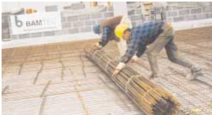
Das Letzte von sieben Elementen wird ausgerollt The last of seven elements is rolled out
