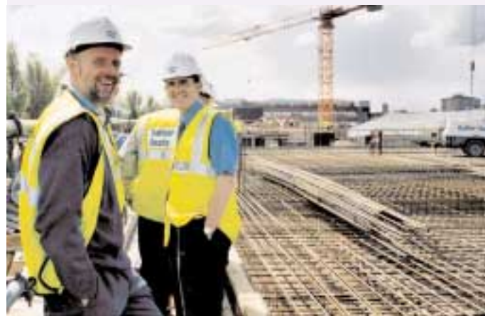
Zufriedene Gesichter bei der Baustellenbesichtigung Satisfied faces at the site inspection.
