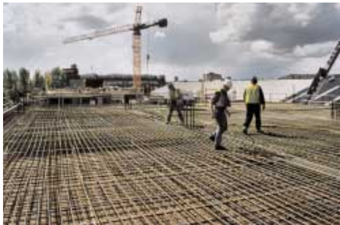
BAMTEC entwickelt sich in Grossbritannien immer mehr zum Mittel um Bauverzögerungen wieder aufzuholen BAMTEC® is being used more and more in Great Britain as a means to make up for construction delays.
