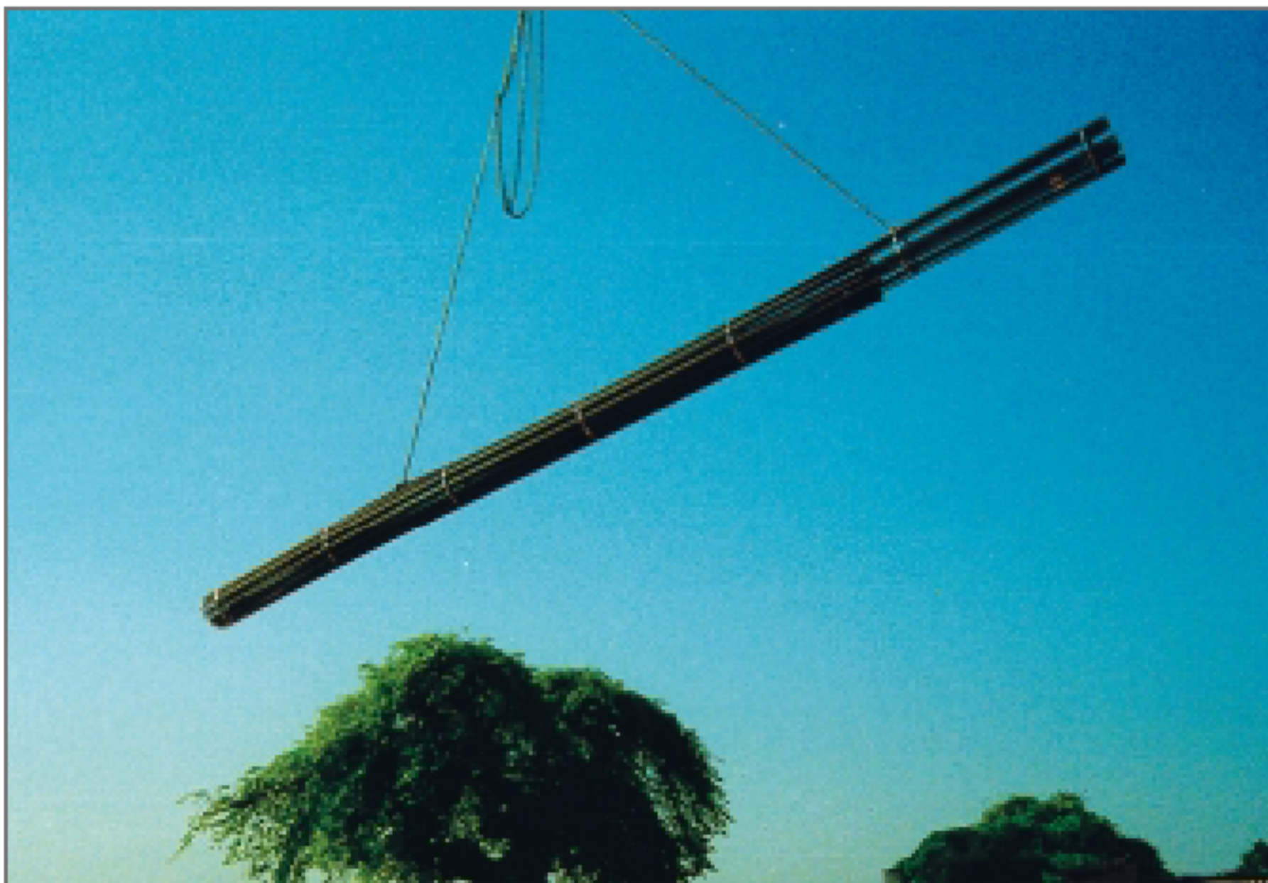
挂钩上的 Bamtec 加固材料。加固钢筋被准确及时地放置在施工地点。
