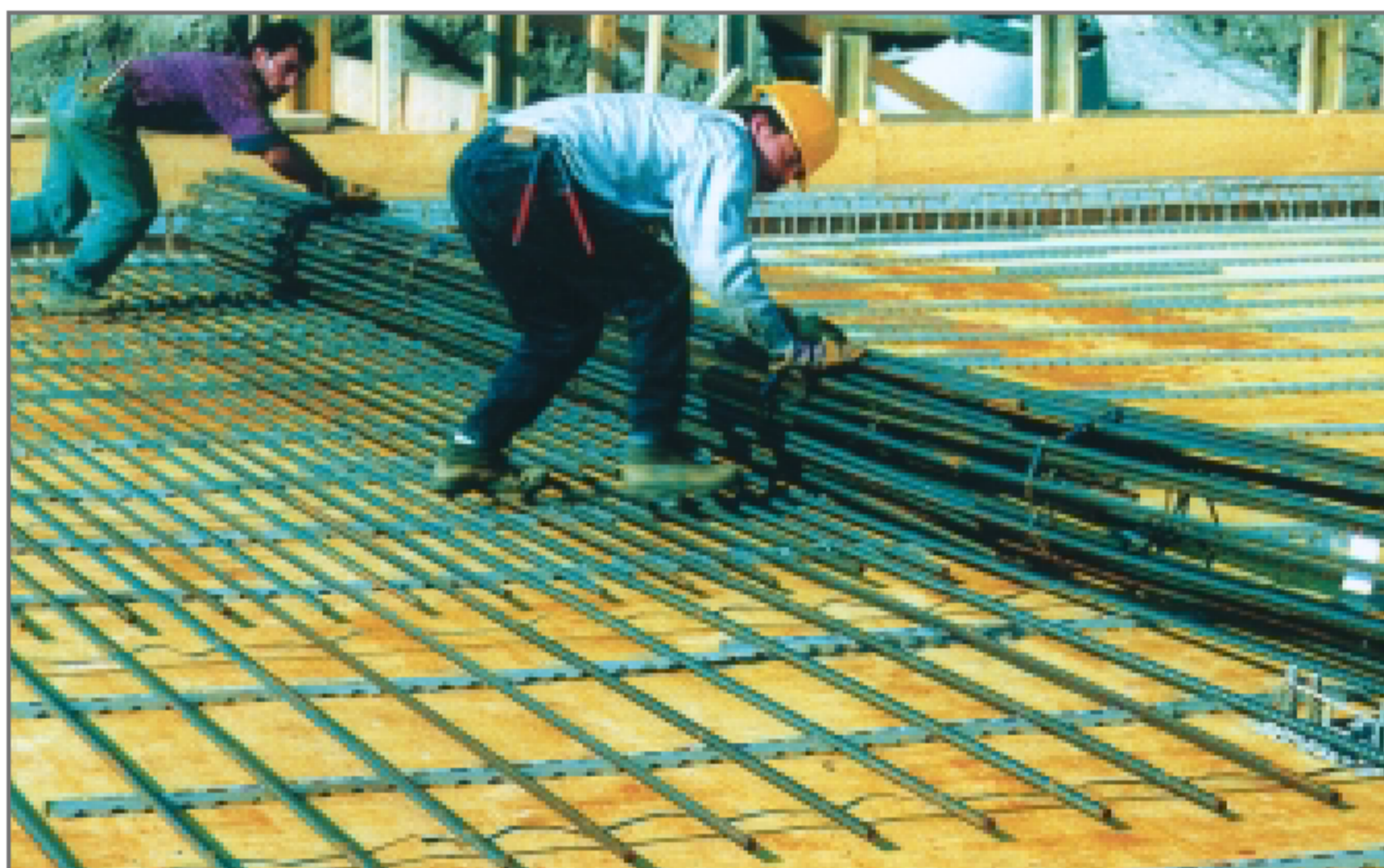
两名工人足以将加固材料在模架上展开。
