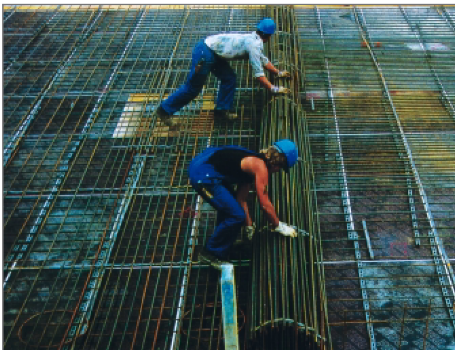
按照不同的结构要求，可以将 4 层加固层叠加铺设。
