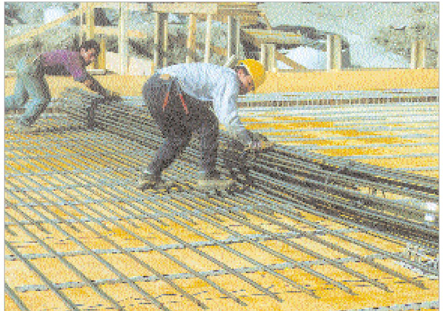
Zwei Arbeiter reichen aus, um die Matte auf der Schalung auszurollen.
