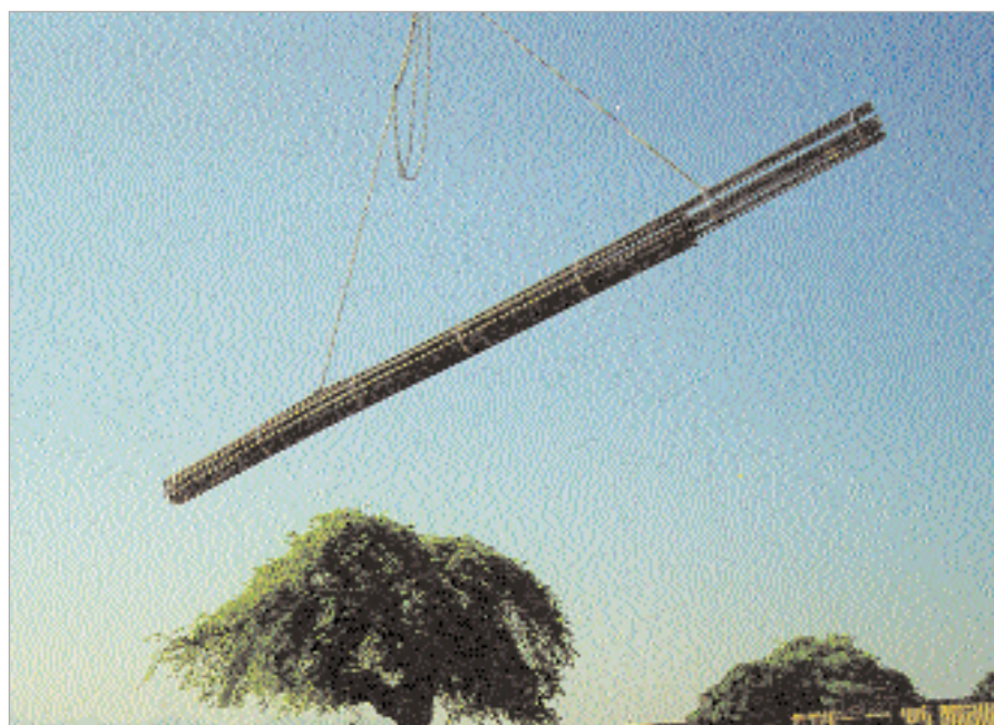
Eine Bamtec-Bewehrungsmatte am Haken. Punktgenau und just-in-time wird der Baustahl an den Einbau-Ort abgelegt.
