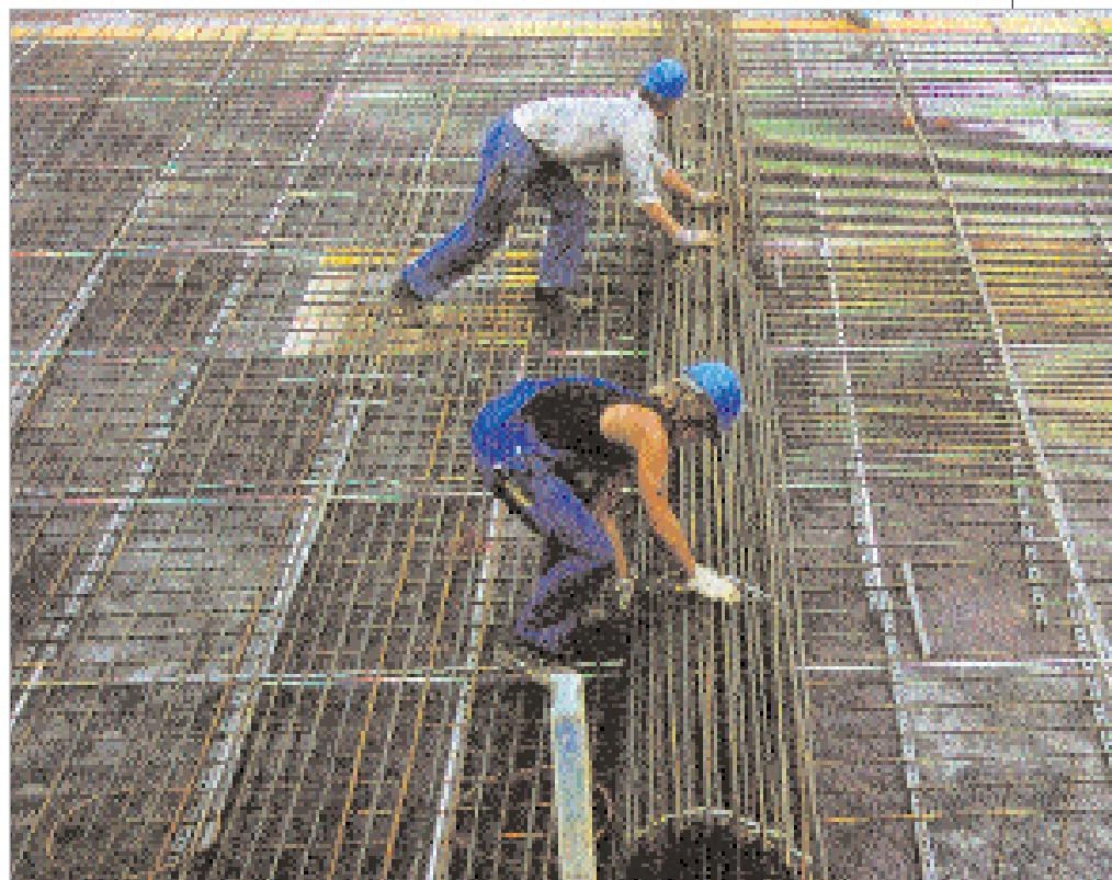
Je nach statischer Berechnung werden vier Lagen Bamtec-Bewehrungsmatten übereinander verlegt.
