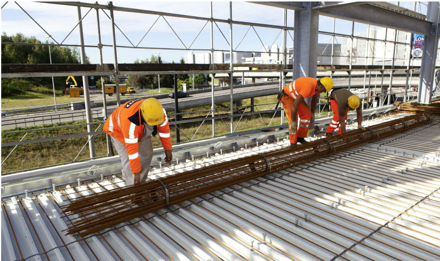
BAMTEC on steel composite construction - Zurich Airport BAMTEC auf Stahlverbundkonstruktion - Flughafen Zürich
