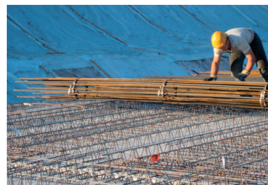
BAMTEC on precast parts BAMTEC auf Elementdecken
