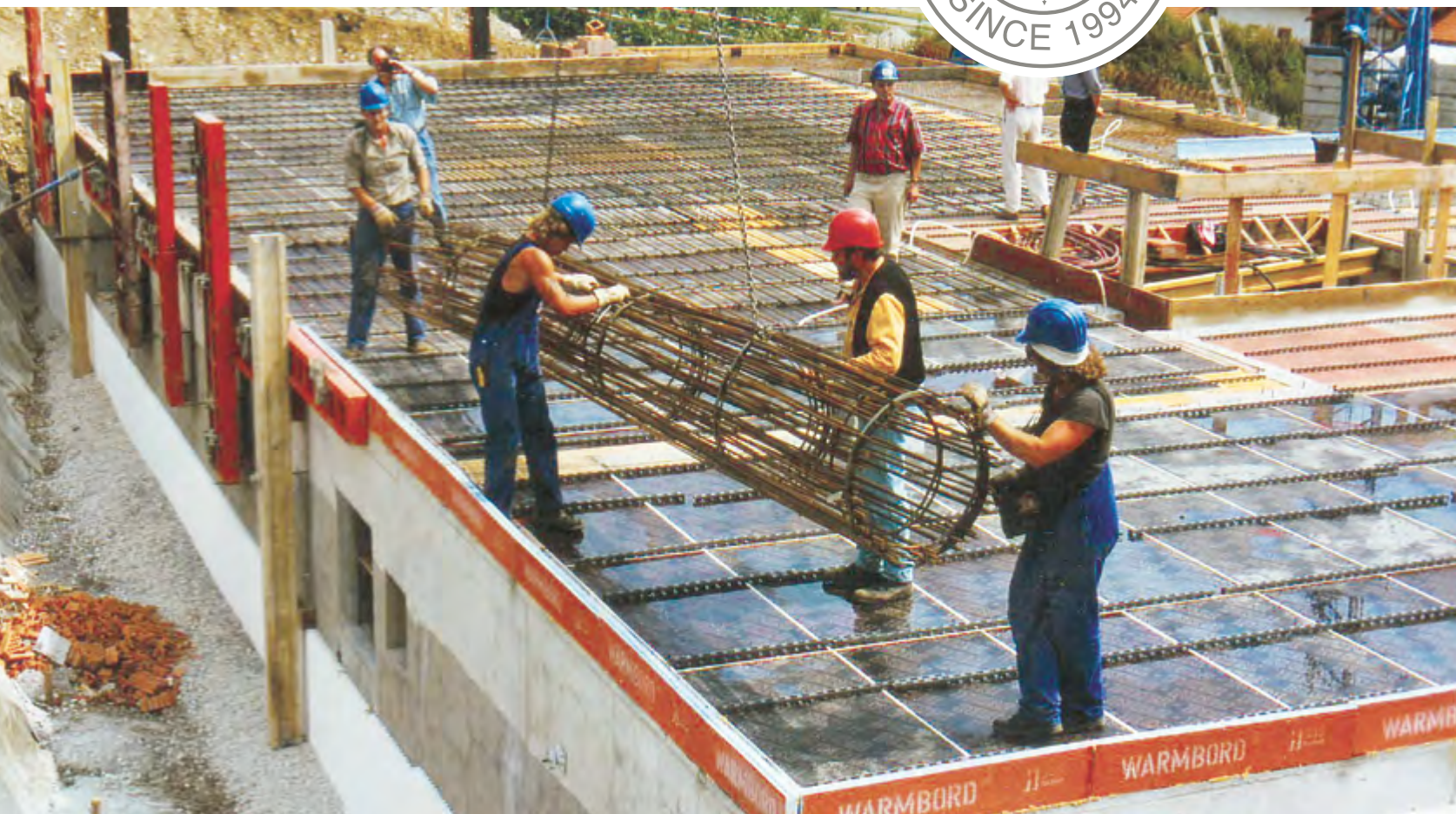
Erste BAMTEC® Baustelle – Oy-Mittelberg im Allgäu, Deutschland
