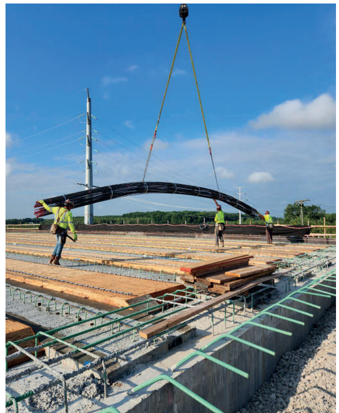
Primo ponte con BAMTEC ® in Ohio, USA
