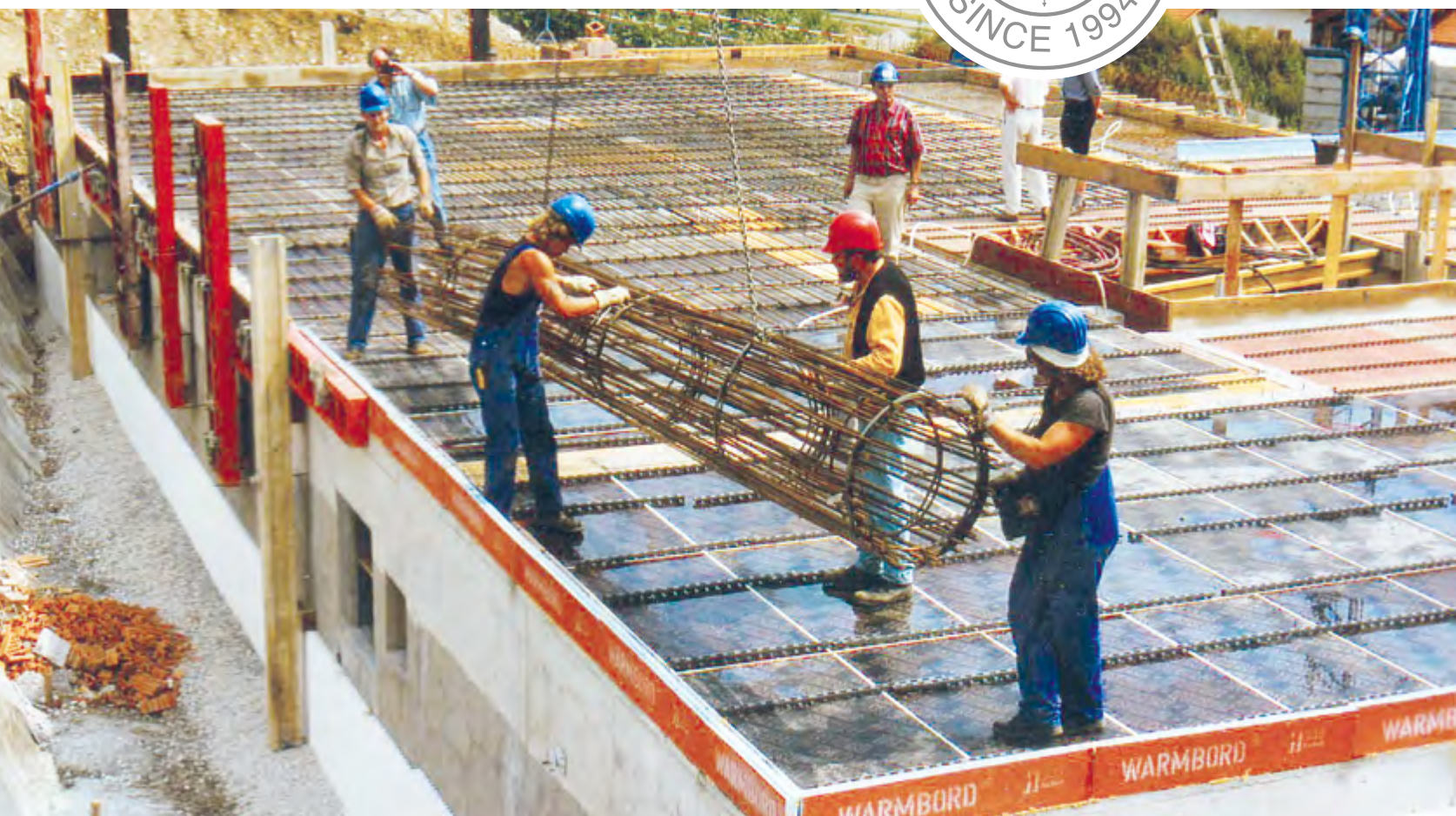
Primo cantiere BAMTEC® – Oy-Mittelberg nell'Algovia, Germania
