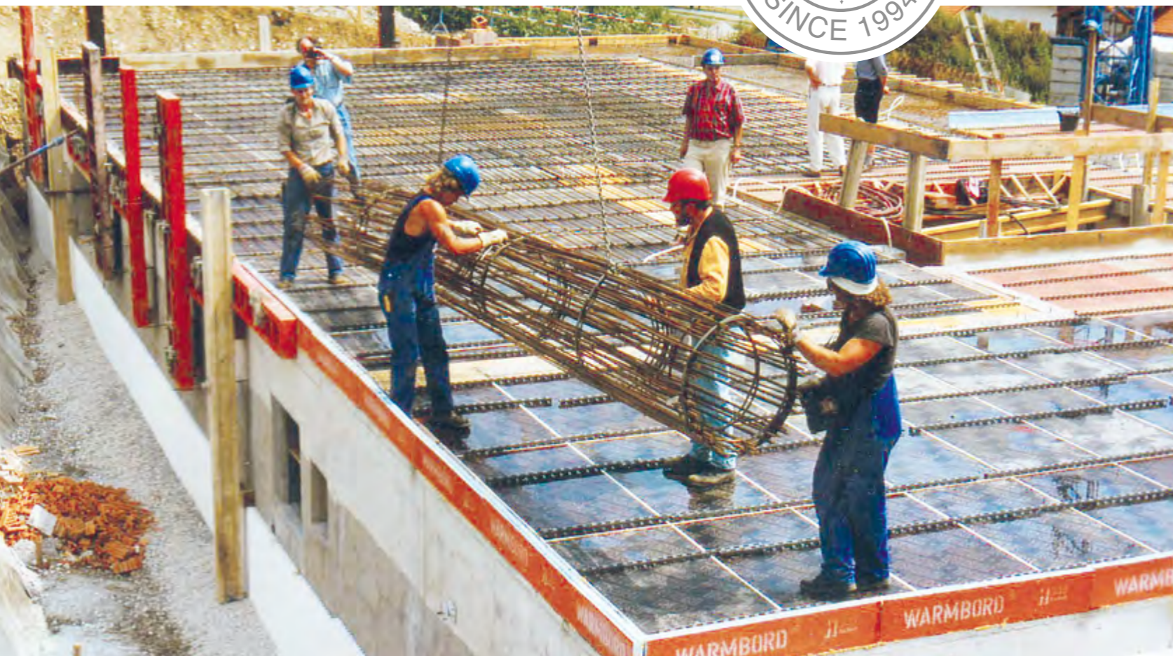
Pierwsza budowa z zastosowaniem BAMTEC® – Oy-Mittelberg w Allgäu, Niemcy
